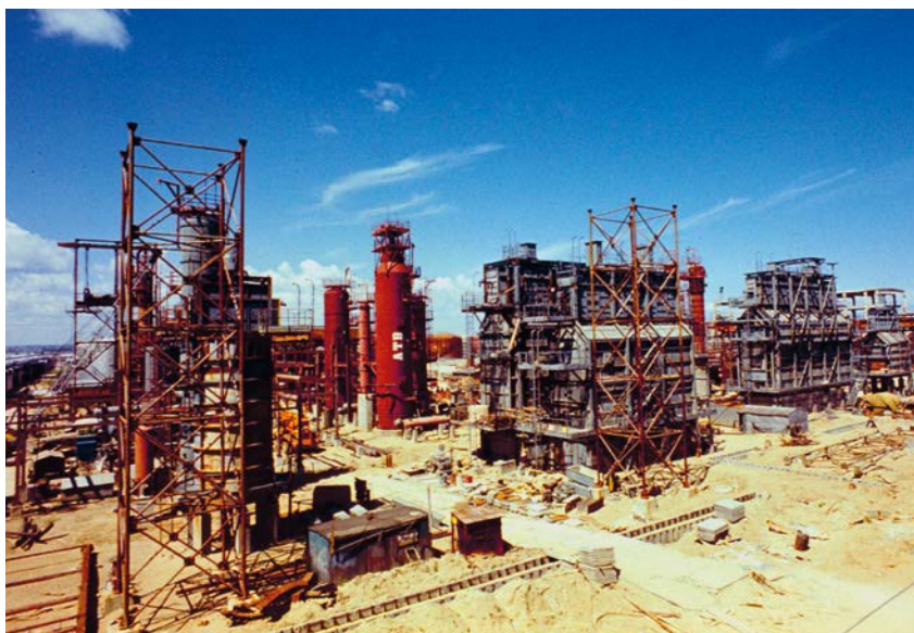
Na zdjęciu: Rafineria Gdańska w budowie - 1975 r. Fot. arch. Grupa LOTOS S.A.
