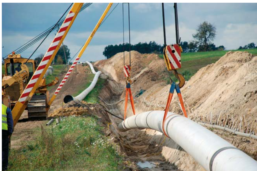
Rembelszczyzna – Gustorzyn w budowie
