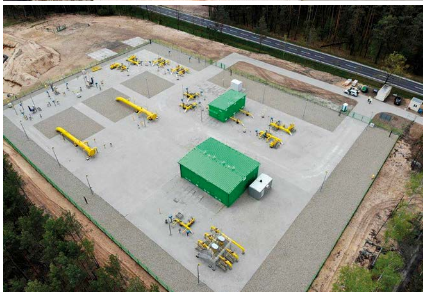
Węzeł gazowy Tworóg. Fot. arch. GAZ-SYSTEM
