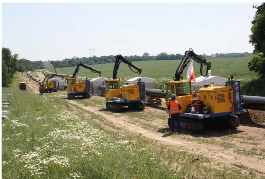
Szczecin – Lwówek w budowie
