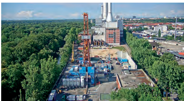
Wiertnia przy elektrowni HKW Süd w Monachium (Bawaria, Niemcy); (źródło: Stadtwerke München, SWM)
