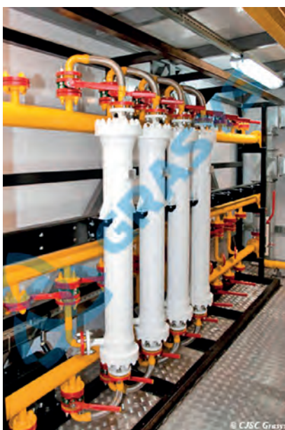
Fot. 1. Instalacja do usuwania H_2S z gazu ziemnego firmy Grasy
