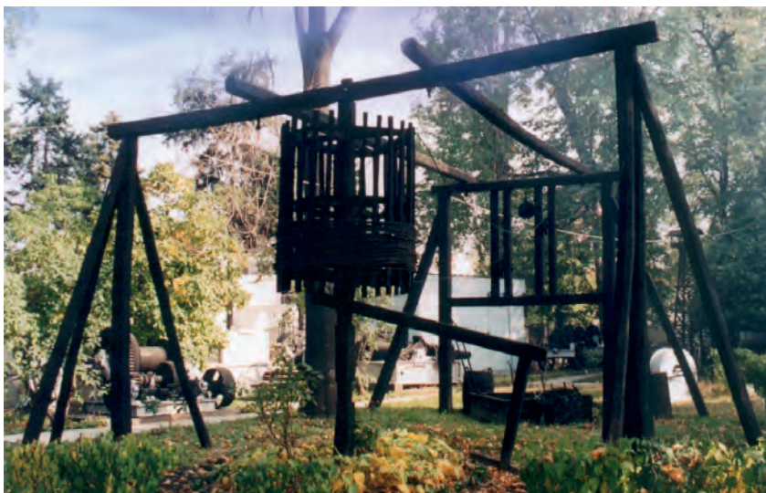
Konny kołowrót do wyciągania urobku i ropy z kopanki. Arch. Muzeum Ropy w Ploeszti
