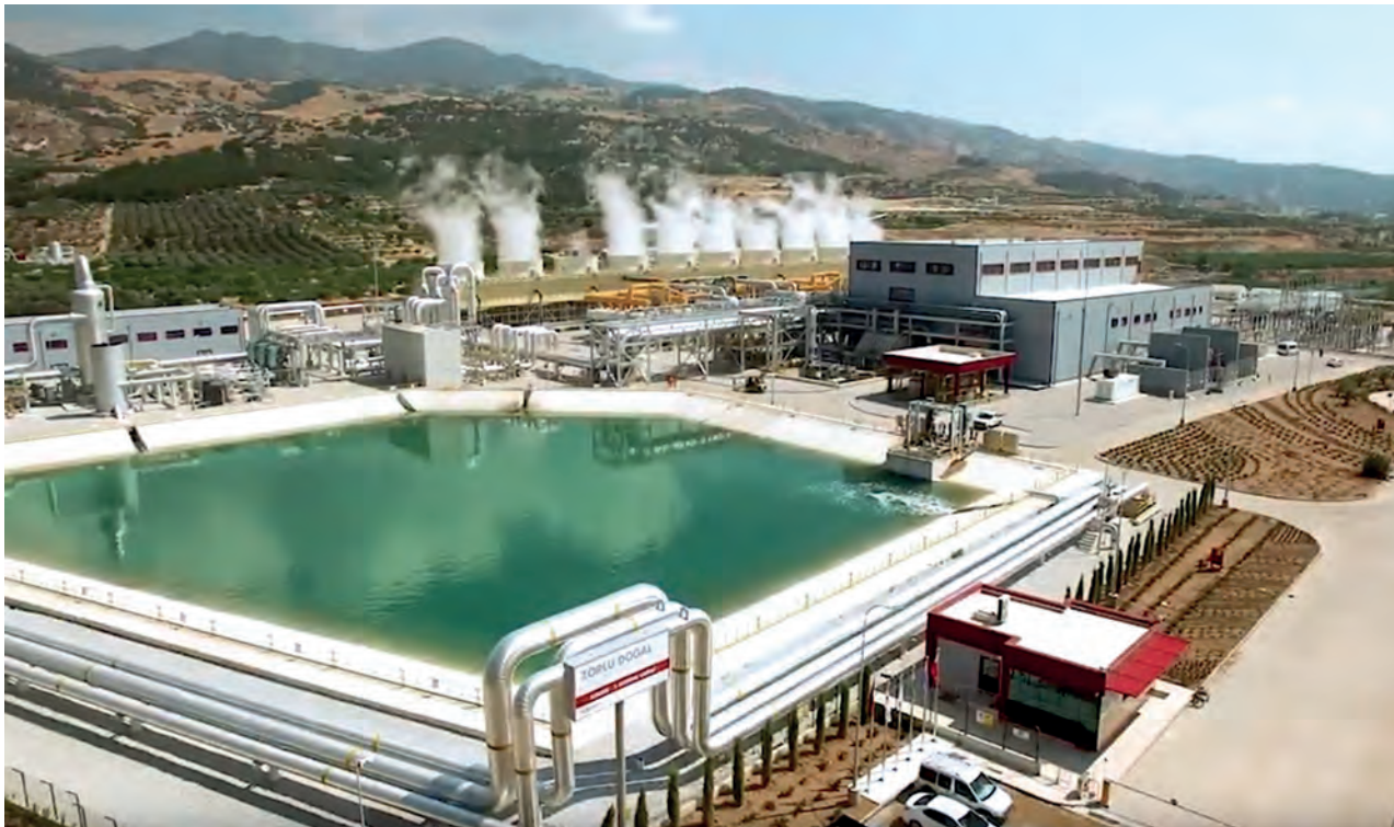
Fig. 2. Elektrownia geotermalna Kizildere (Turcja) (źródło: Zorlu Energy)
