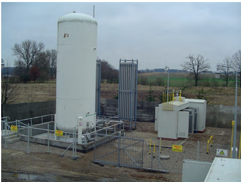
Fot. 1. Widok stacji regazyfikacji LNG [7]
