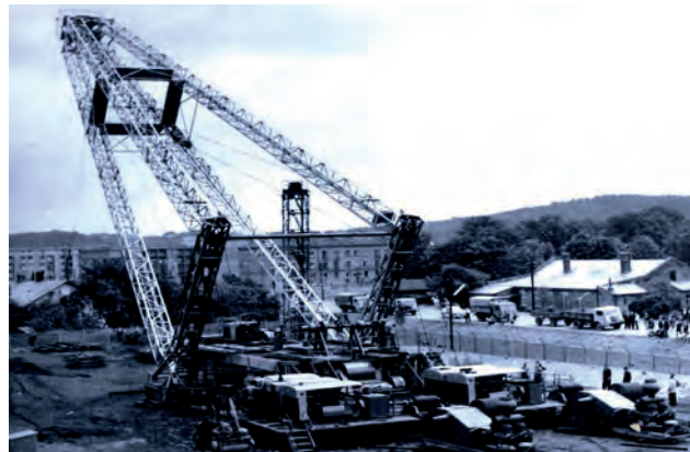
Stawianie wieży urządzenia WOS-2000 na placu montażowym w Fabryce Maszyn „Glinik” w Gorlicach w latach 60 ubiegłego wieku. Fot. ze zbiorów S. Karlica
